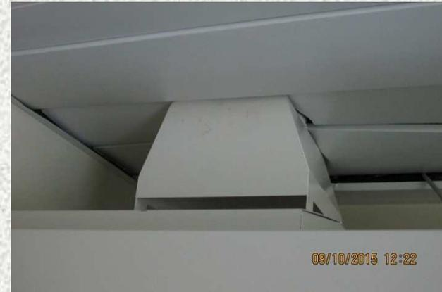
*Le cabine di sicurezza con ventilatore di espulsione autonomo devono essere collegate al sistema di espulsione del laboratorio mediante una connessione aperta ("**thimble**"), sagomata a cappa e dimensionata in modo che l'impianto **smaltisca attraverso essa la portata di espulsione della cabina più una quota parte prelevata dall'ambiente**; questo dispositivo costituisce una disconnessione aeraulica tra i due sistemi e **impedisce che il funzionamento dell'uno crei sbilanciamenti sull'altro***
