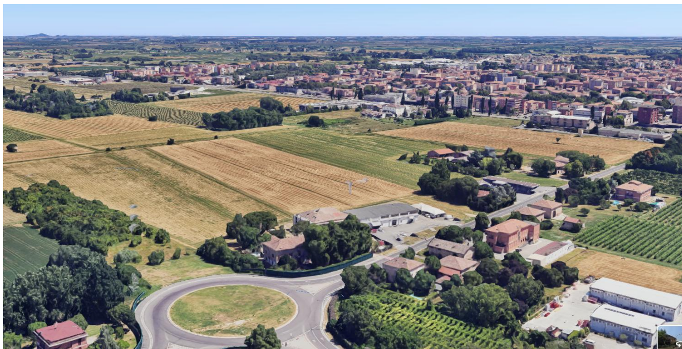
Figura 6 Vista aerea dell'area da sud ovest - via Guastalla
