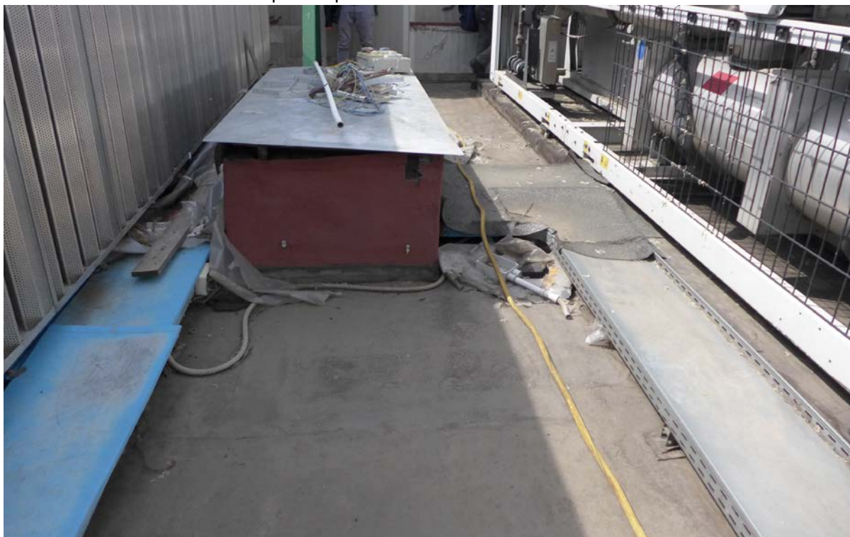
Fotografia n3 – Manufatto uscita cavi in copertura
