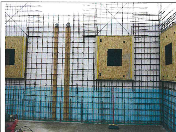
UNICA COSTRUZIONI - fase costruzione
