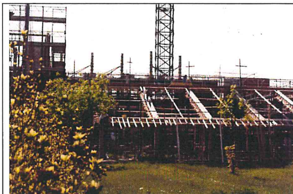
MODENA- VI Strutt. RSA-fase di costruz.
