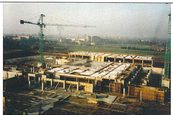
Osp. di Baggiovara – Mo – Fase di costruz.
