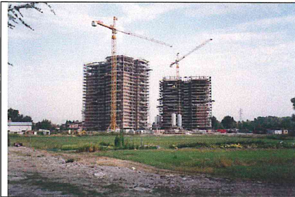
MODENA – Le Torri – Fase di costruzione
