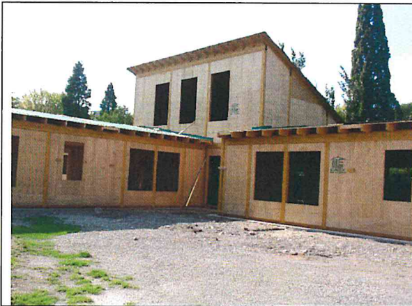
ALIANTE Soc. Coop – centro socio riabilitativo residenziale - fase costruzione
