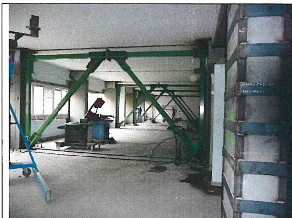
Policlinico MO – Miglioramento sismico
