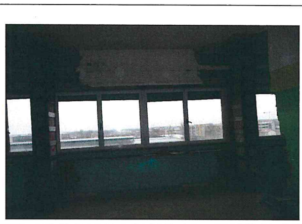
Policlinico MO – Miglioramento sismico
