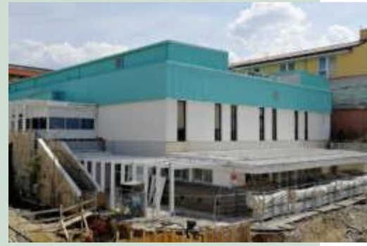
Ristrutturazione Centro del Cuore
