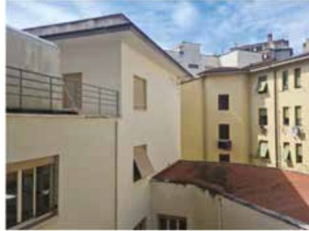
Foto 3 – Abitazioni (ricettori) prospiciente lato destro del terrazzino dist 22,20 e 18,40 m
