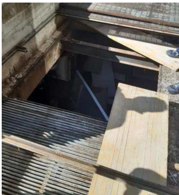
Fig. 28 - Accesso alla centrale termica
