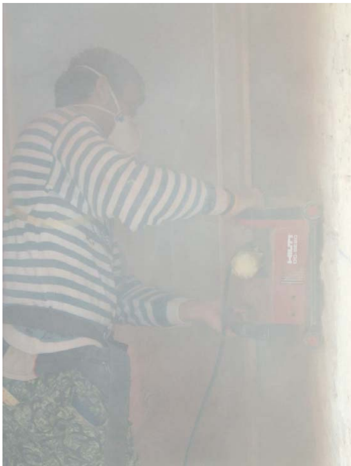
Esecuzione del taglio (mattoni pieni) con la scanalatrice in assenza di dispositivo aspirante
