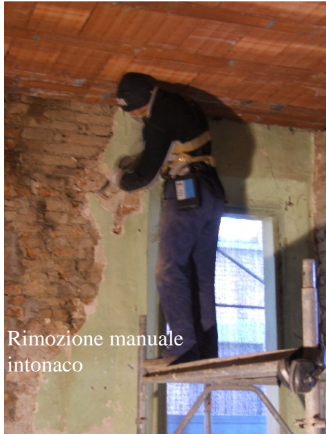
Demolizione manuale inframezzo
