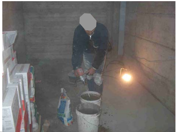
Preparazione dell'impasto: miscelazione con attrezzo ad elica applicato a trapano
