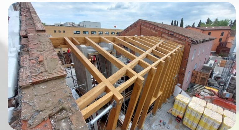
Ristrutturazione edificio Hera (BO) Edifici direzionali
