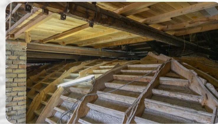
Miglioramento sismico complesso “Quattro Cantoni” a L’Aquila Edifici vincolati
