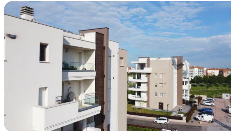
Fotografie palazzine residenziali realizzate
