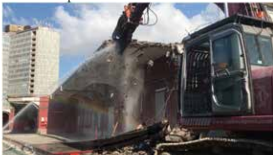
Foto 1- Alcune fasi della demolizione
