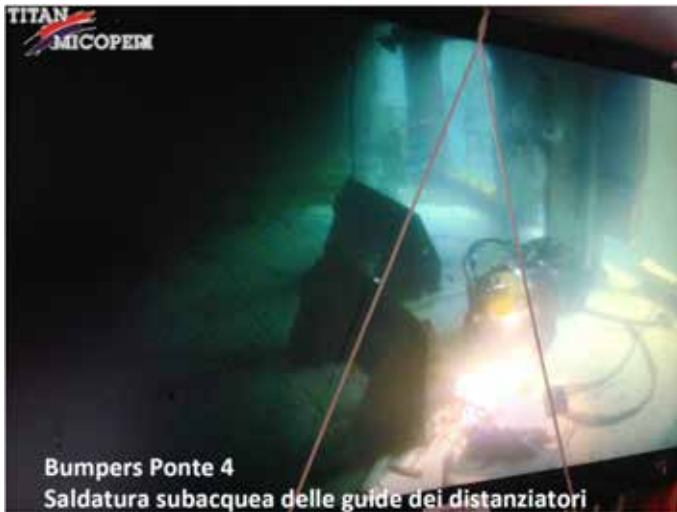
Figura 6: Distanziatori utilizzati per appoggiare i cassoni di spinta
