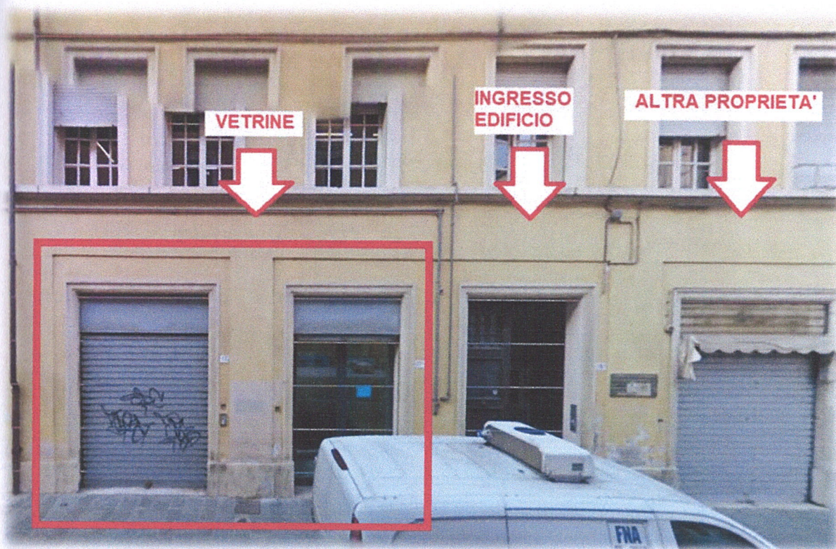
Prospetto in angolo via Sgarzeria (particolare)
