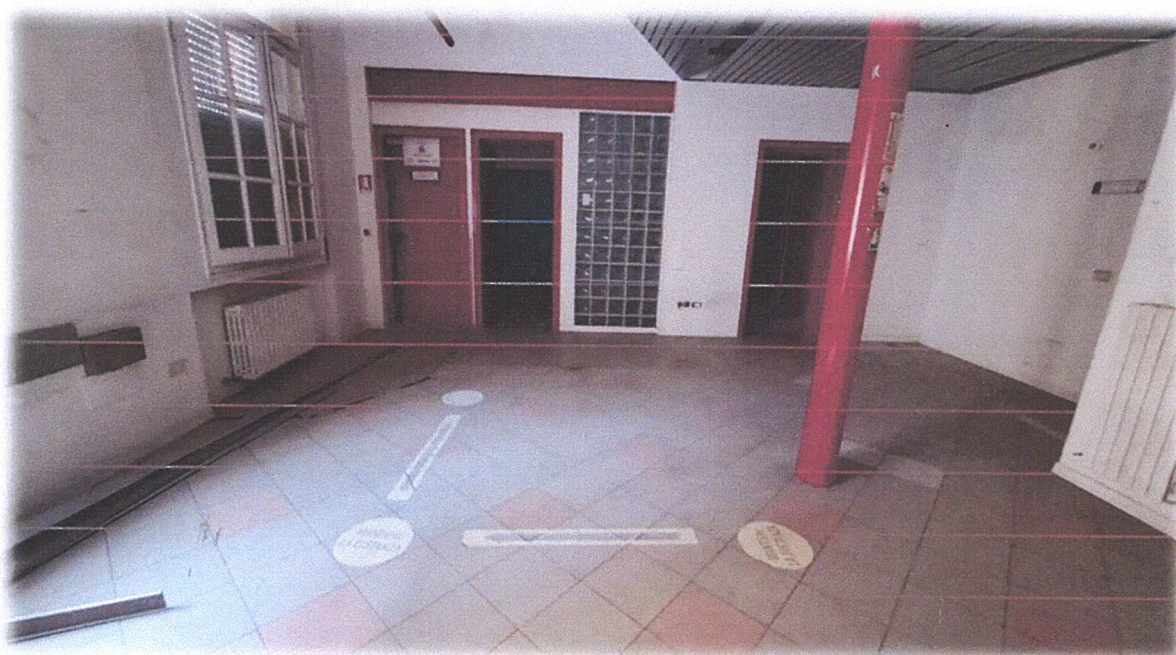
Locali interni al piano terra
