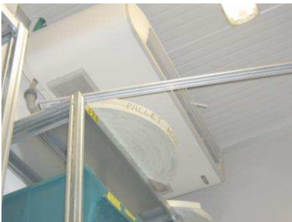
Climatizzare a soffitto nelle sale dei videoterminali
