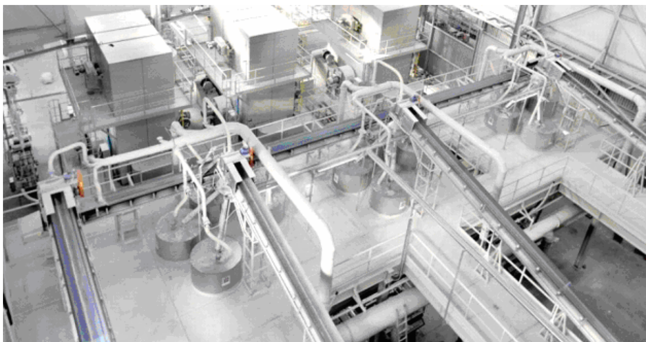
Sistemazione della pensilina per l'alimentazione delle tramogge delle presse.
