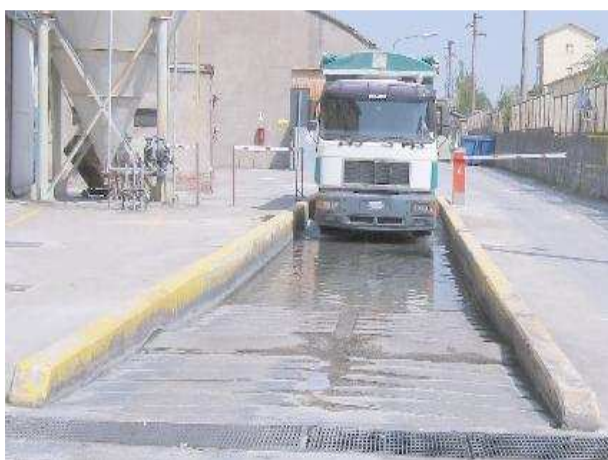
Sistema di pulizia ad umido delle ruote
