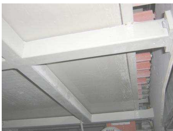
Sotto la rulliera un pannello convoglia le polveri nel punto di raccolta, evitando la caduta al suolo.
