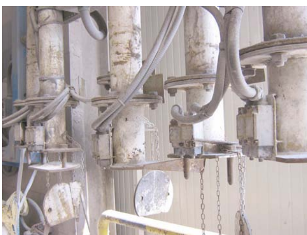
Particolari: gli agganci per lo scarico pneumatico e il microcontatto del circuito di controllo.
