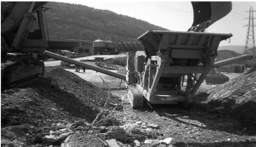
Figura 2b: escavatore + frantoio - vaglio
