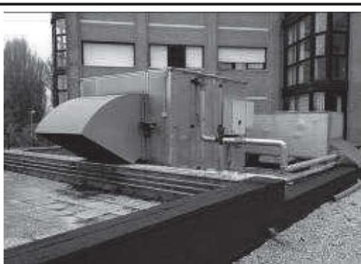
**Figura 2:** UTA - impianto immissione – posizionamento a tetto
