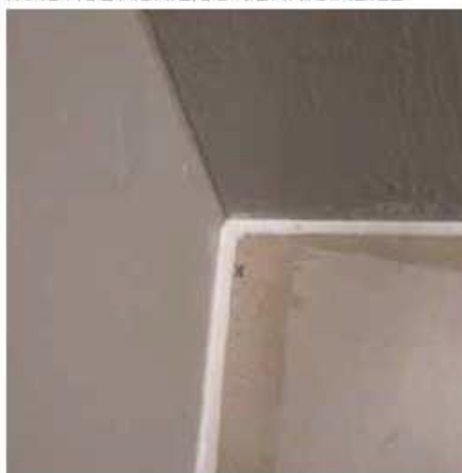
STUCCATURA DEI GIUNTI TRAMITE MASTICE ACRILICO VERNICIABILE
